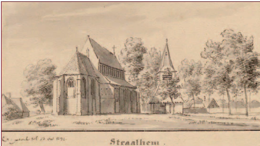
Afbeelding 4. Door Cornelis Pronk (1691-1759) gemaakte tekening van de kerk van Stratum in 1732, gezien vanuit het oosten. Rechts het luidhuis. Collectie Regionaal Historisch Centrum Eindhoven.
